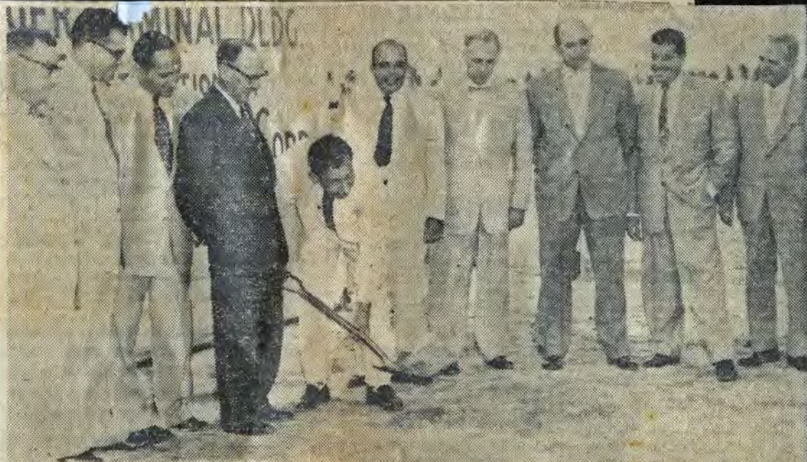
ECHA PRIMERA PALA DE TIERRA — En presencia de varios funcionarios del Gobierno y de ingenieros encargados del proyecto, el Director de la Autoridad de Transporte, Salvador V. Caro, se dispone a echar la primera pala de tierra para la construcción del Edificio Terminal del Aeropuerto Internacional.
